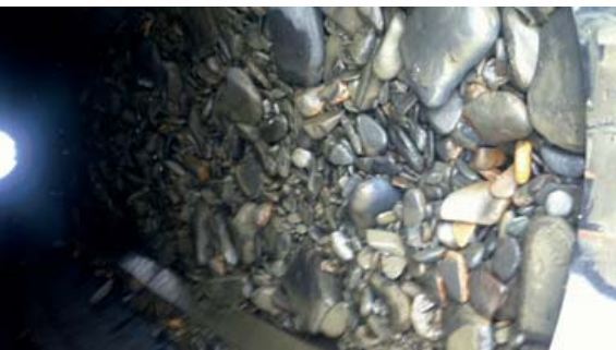
Рис. 2. Внутренний вид барабана скруббера «Sepro Mineral Systems» после остановки
