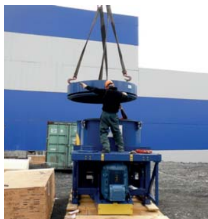
Поставка и монтаж концентраторов SB5200 на ЗИФ «Наталка»
